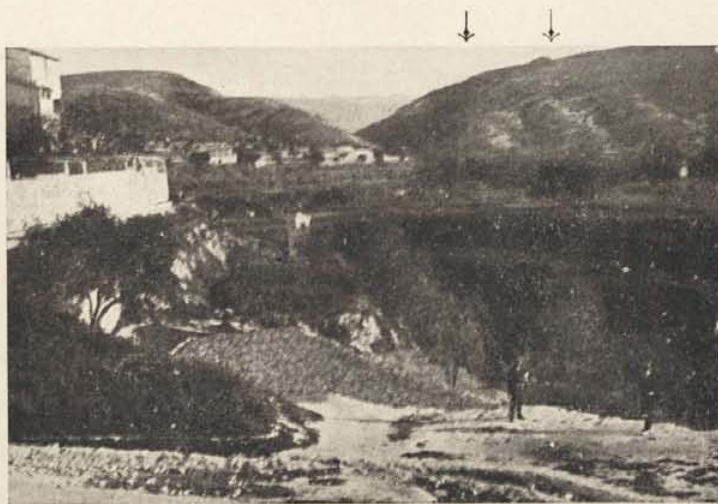
A.—Castellet del Porquet: Vista d'un fos i dels restes de mur.
