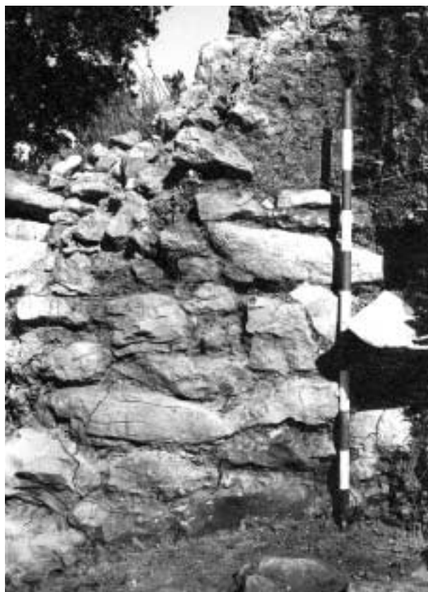
Fig. 10.- El Tossalet. Detalle del paramento izquierdo.
