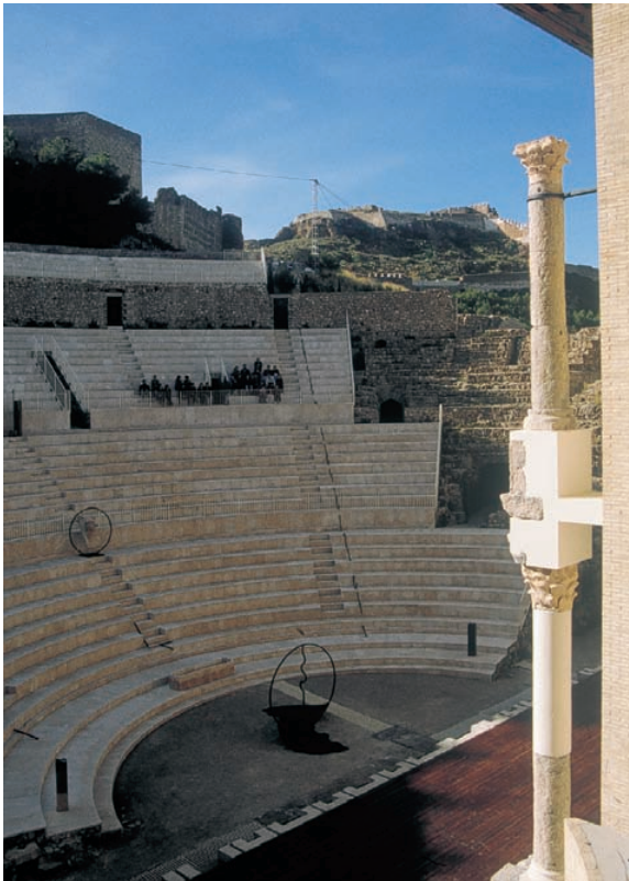
Última restauració-rehabilitació del teatre romà de Sagunt. [Arxiu SIP].
