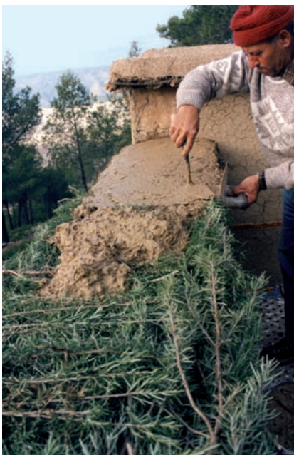
11. 1. Construcción de los aleros. 2. Detalle de los mismos una vez acabados.
