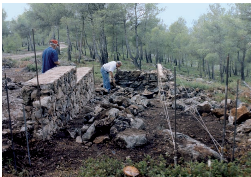
4. Construcción de los zócalos de la casa.
