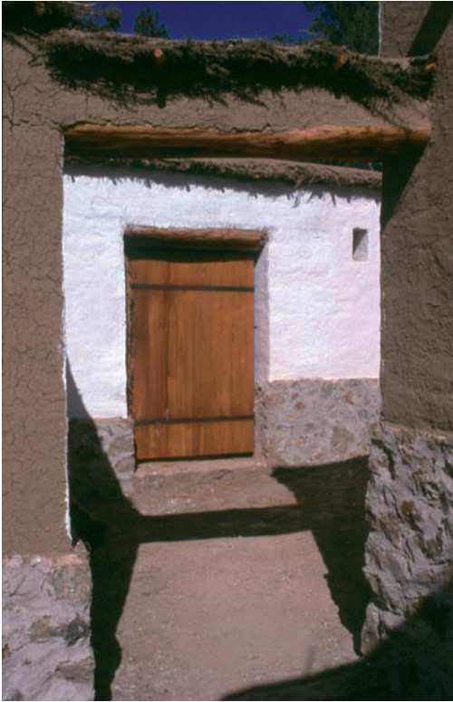
8. 1. Puerta de tablonos unidos por dos pletinas de hierro instalada en el almacén de la casa. 2. Una de las puertas del cuerpo principal de la casa, desde el interior.
