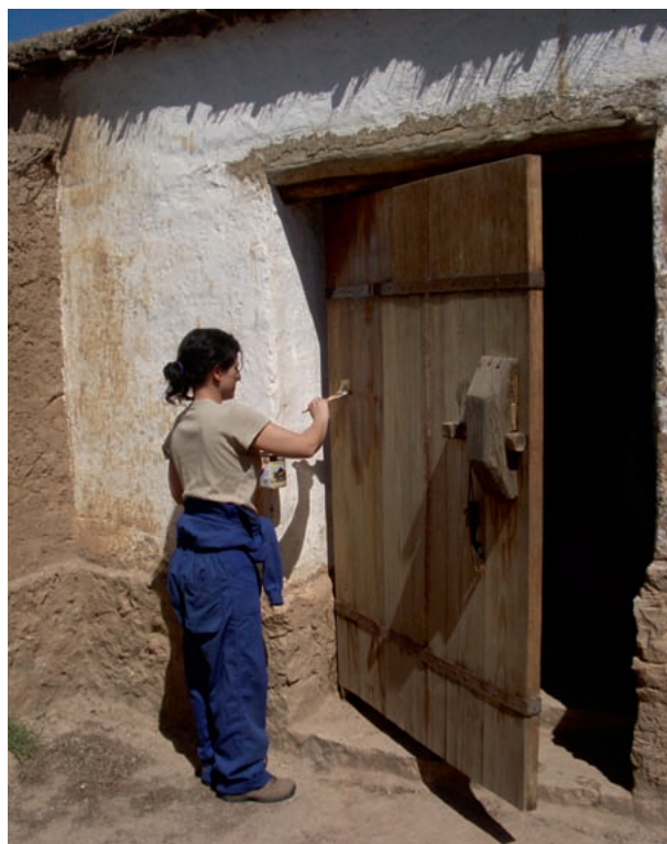
23. Trabajos de mantenimiento de las puertas (año 2007).
