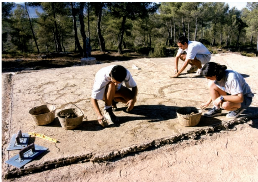
20. Rejuntado de grietas durante la segunda reparación del techo (año 2000).
