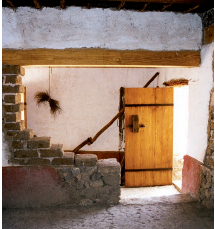
8. 1. Puerta de tablonos unidos por dos pletinas de hierro instalada en el almacén de la casa. 2. Una de las puertas del cuerpo principal de la casa, desde el interior.
