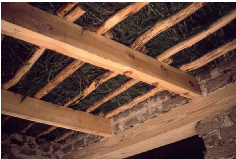
10. El entramado de vigas, rollizos y cubierta vegetal que sustenta la capa de barro del techo, visto desde el interior.
