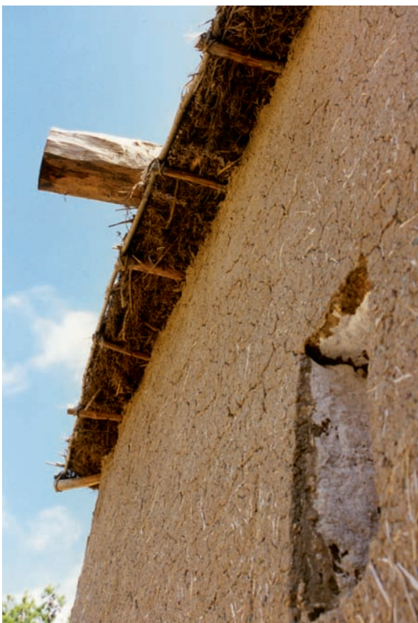
12. Una de las gárgolas de madera para el desagüe desde el techo.
