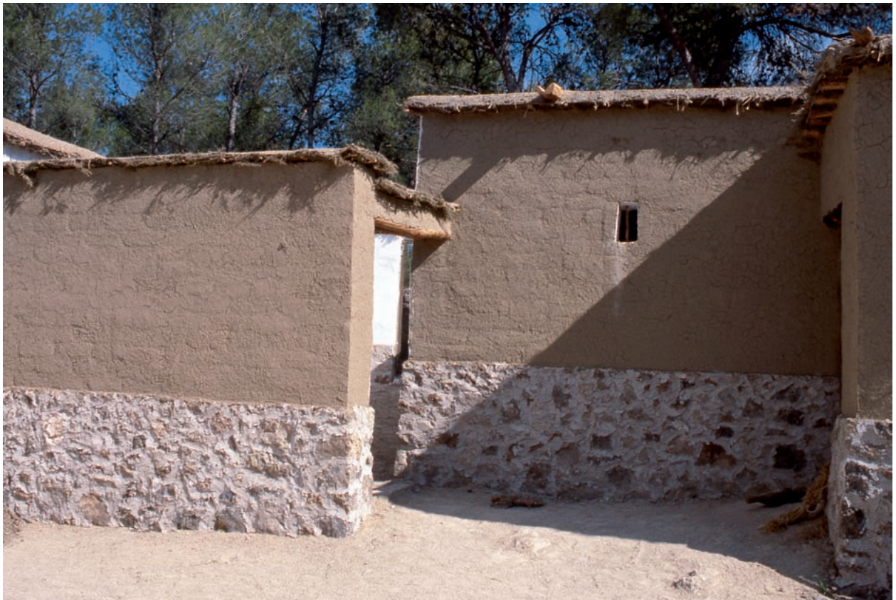
13. 1. Fachada sur de la casa, una vez finalizados los trabajos, con las paredes de adobe encaladas y el zócalo de piedra visto. 2. Fachada oeste de la casa sin encalar.
