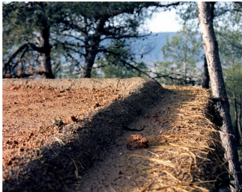
11. 1. Construcción de los aleros. 2. Detalle de los mismos una vez acabados.
