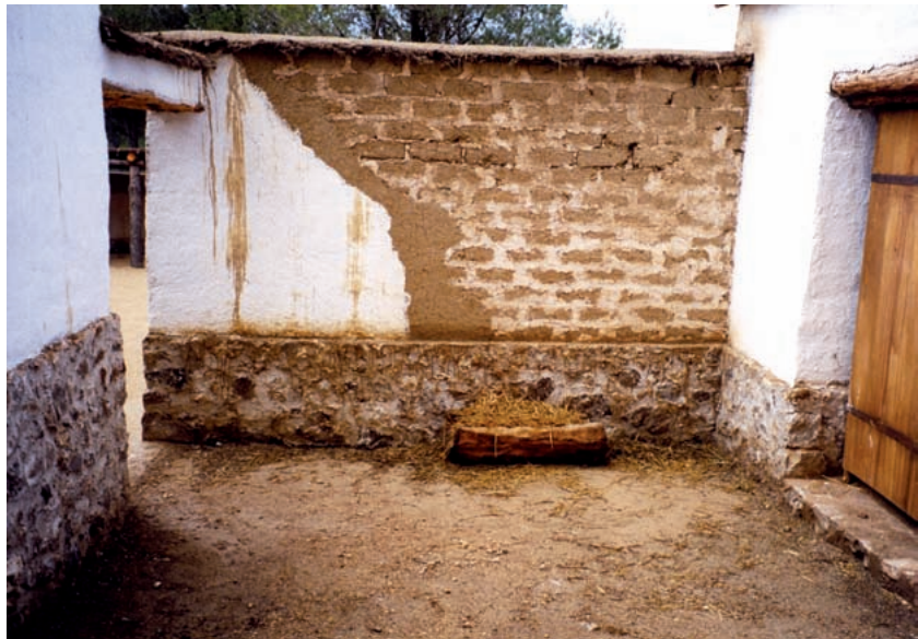
18. El patio de la casa, con el abrevadero. La secuencia de la construcción se aprecia en uno de los muros: zócalo, adobes, enlucido y encalado.
