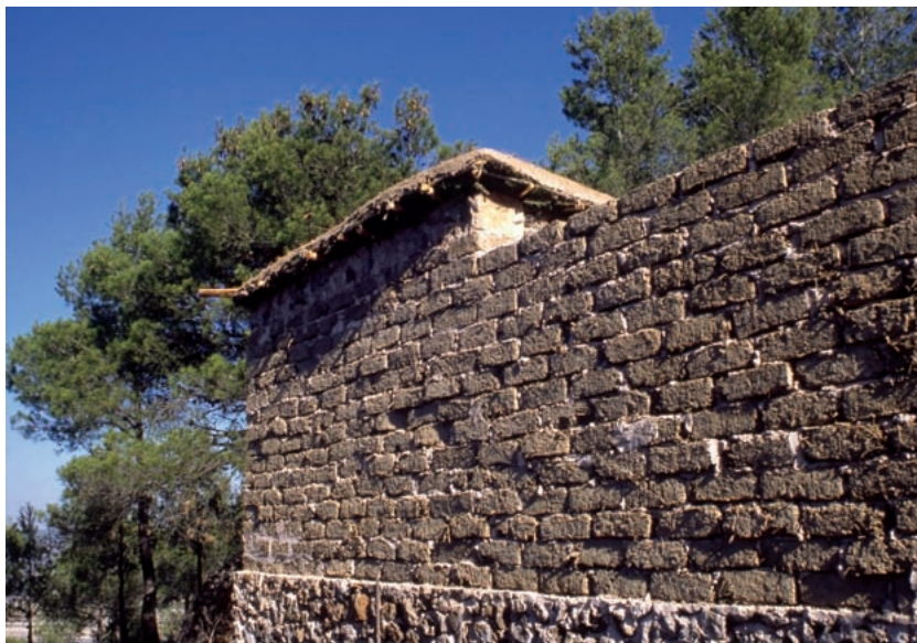
6. Alzado de una de las paredes de la casa, con los adobes vistos, antes de ser enlucidos.
