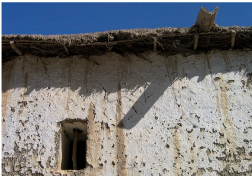
7. Ventanuco en una de las paredes de la casa.
