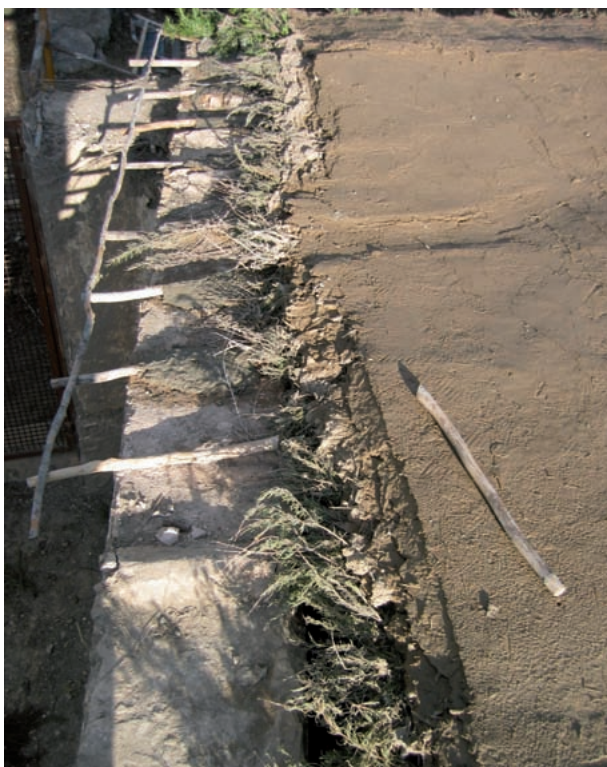
22. Colocación de los aleros del cuerpo principal de la casa (otoño de 2004).
