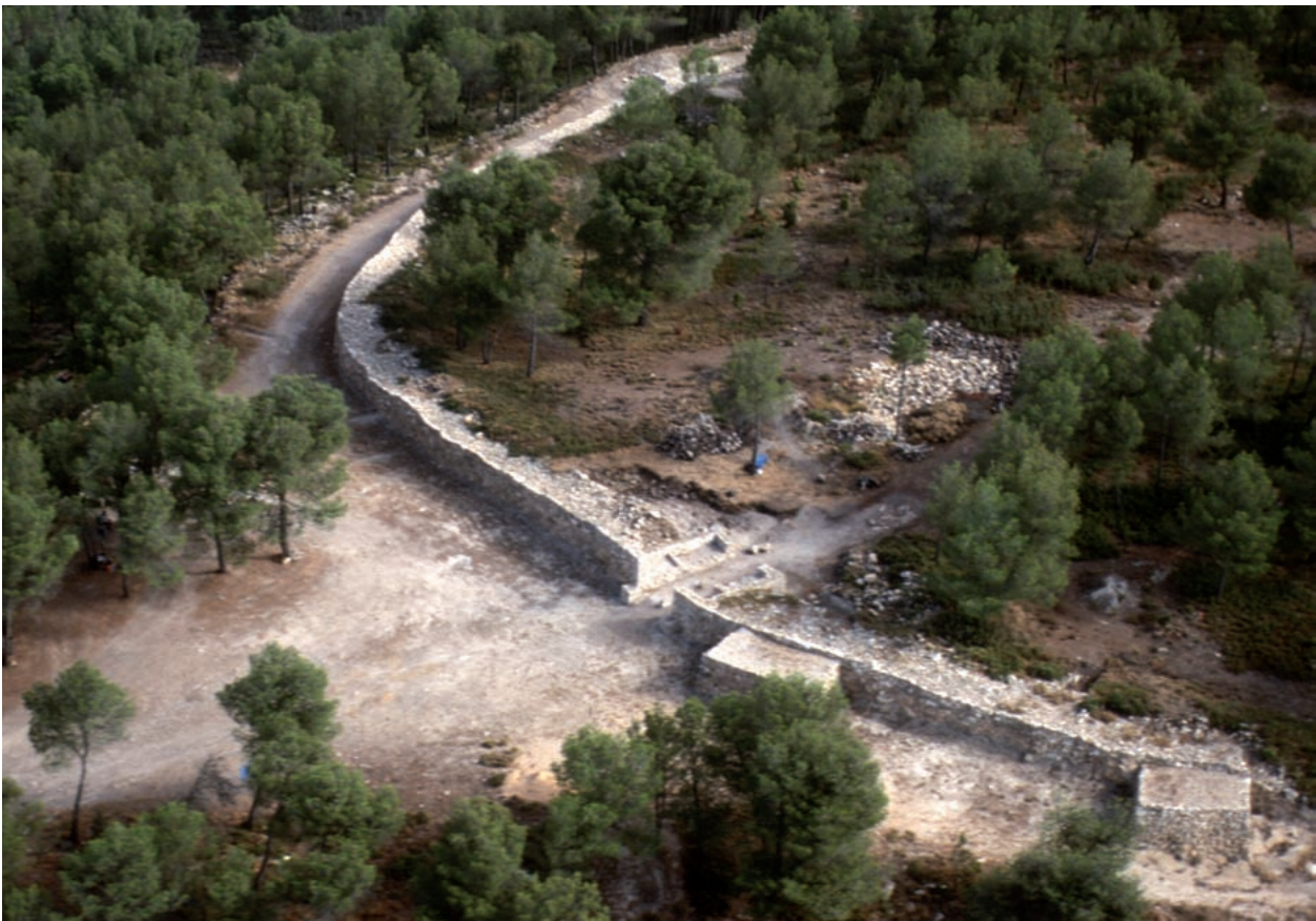
5. Vista aérea del frente oeste de la muralla, con la puerta y las dos torres (año 2000).
