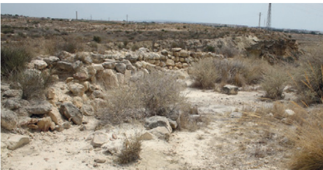
Figura 3.6. Estado de conservación del espacio A de Caramoro I en 2014.
