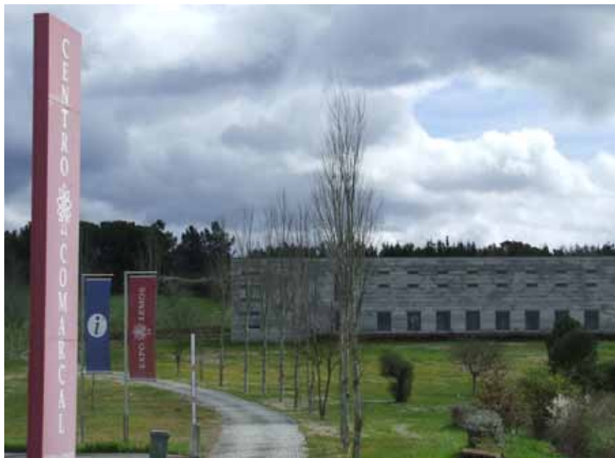
FIGURA 7. Edificio de Expolemos, a 2 km de Monforte de Lemos, en un prado al lado de la N-120. Una ruina arqueológica del Plan de Desarrollo Comarcal de Galicia.
